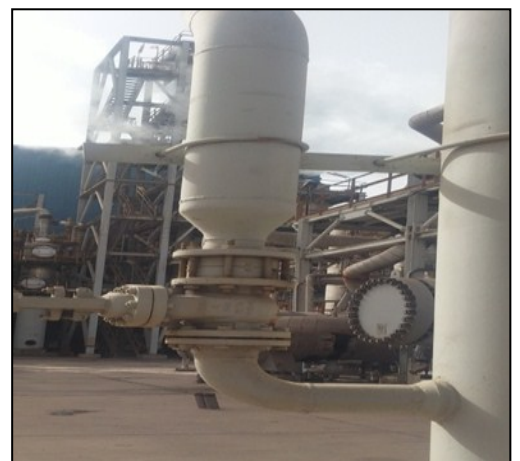
نصب Rupture Disc در ورودی شیر
